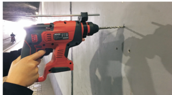
2、标好钻孔位置，用电钻打孔
