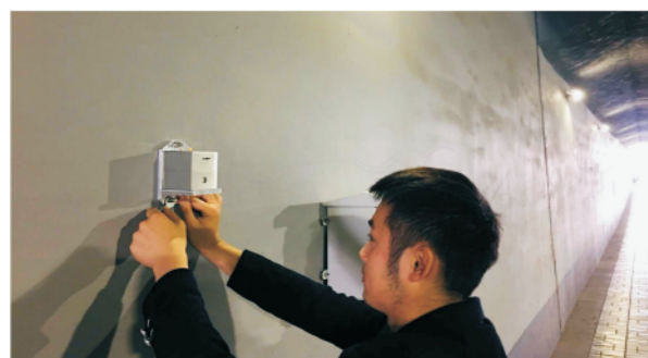
3、仪器与夹具组装好后通过膨胀螺丝固定在墙面上
