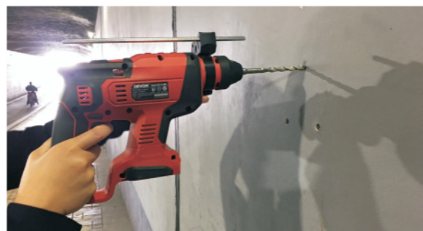
2、标好钻孔位置，用电钻打孔
