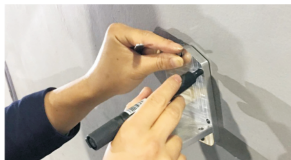
1、选择平整墙面为安装点，反映真实振动
